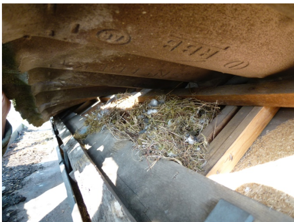
Links een nest van een huismus onder de dakpan (bron: foto: Miecon BV).
